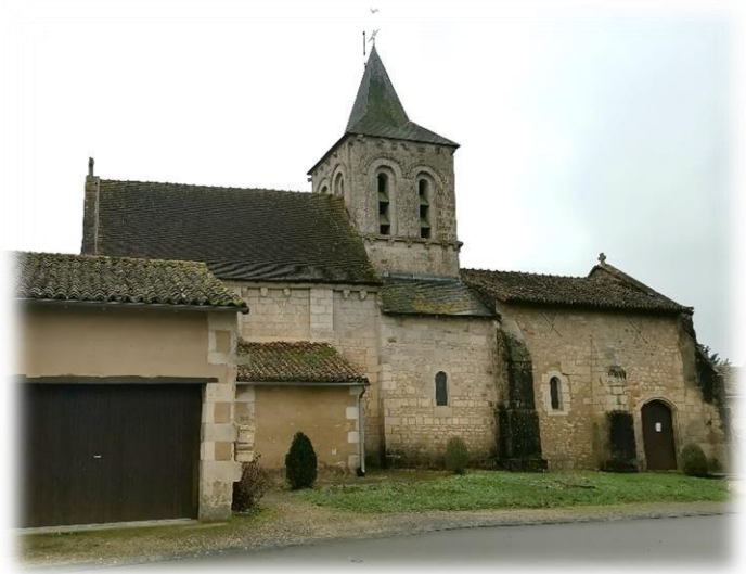
Figure 40 : Église Saint Martin à Pouillé
